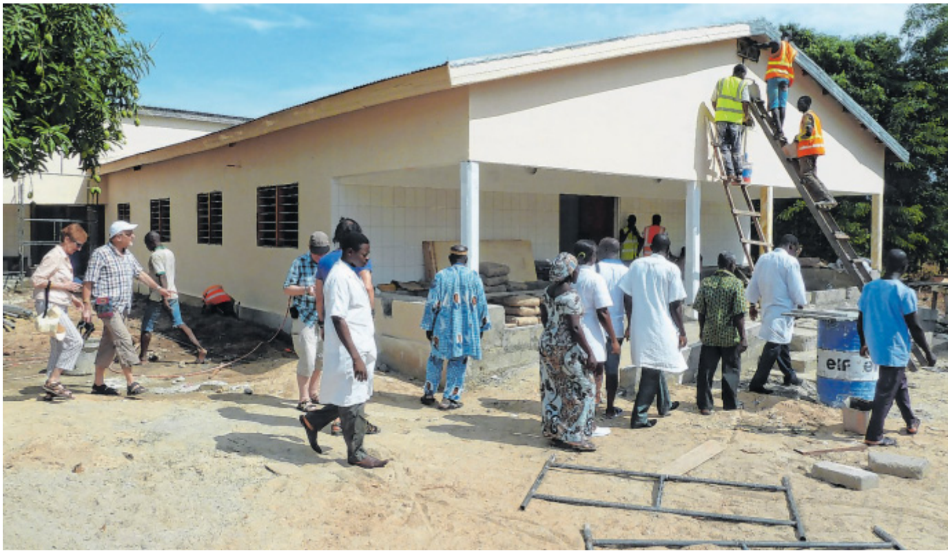
Die neue Entbindungsstation: Das Bauprojekt ist inzwischen vollendet worden. 83.000 Euro hat der Neubau gekostet. Das Foto entstand bei den Arbeiten im März dieses Jahres im Rahmen der letzten Inspektionsreise des Fördervereins nach Togo.
