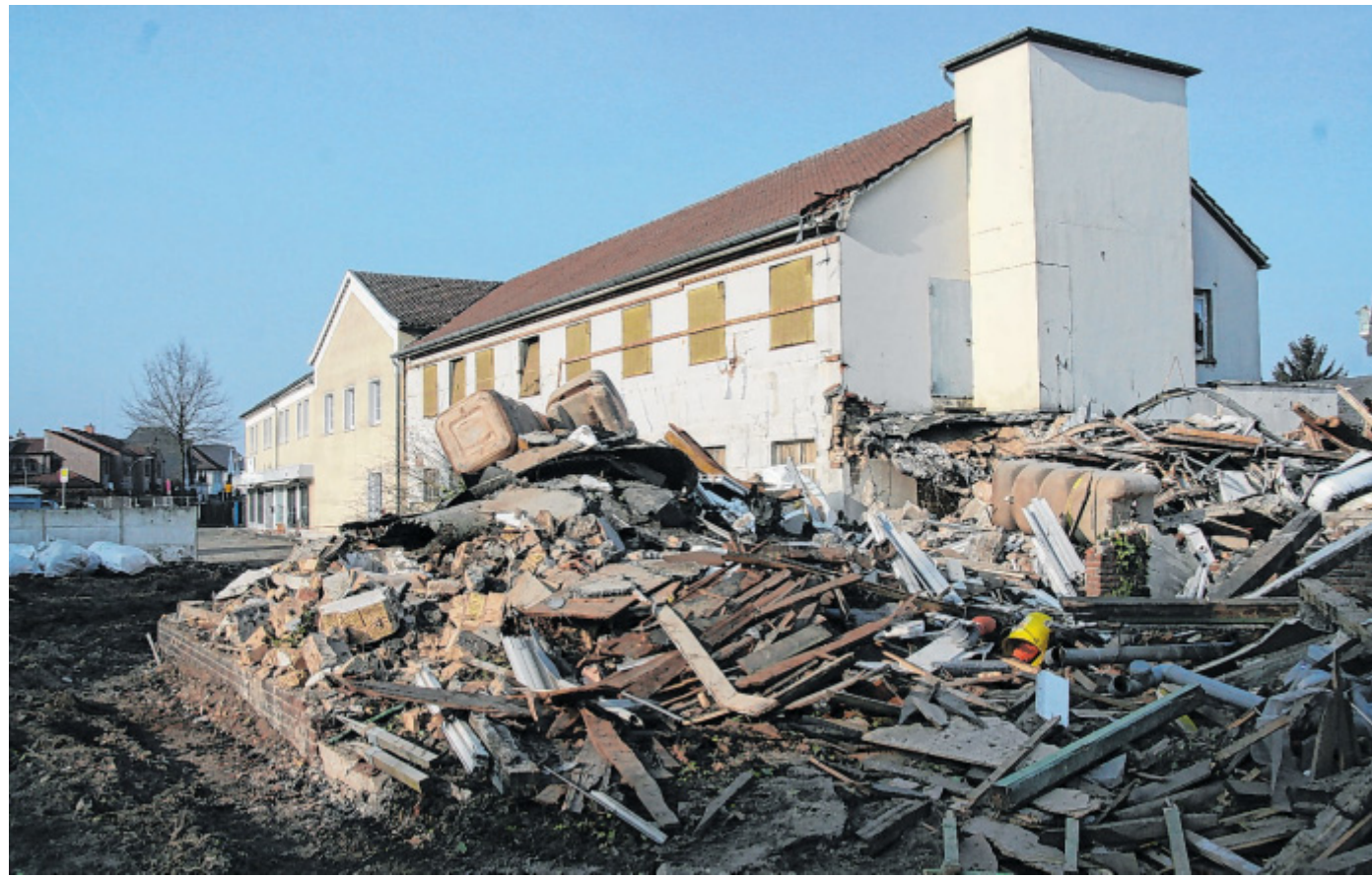
Haufenweise Schutt: Mitarbeiter des Abbruchunternehmens haben die Reste der bereits an der Bielefelder Straße abgerissenen Wohnhäuser zusammengeschaubert. Nun weicht auch das letzte Gebäude auf dem Eckgrundstück.
