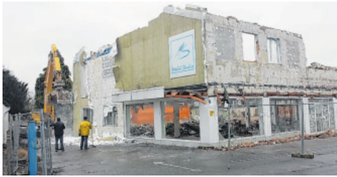
Das Ende eines Möbel-Studios: Der Abriss des Gebäudes an der Breiten Straße schreitet voran.
