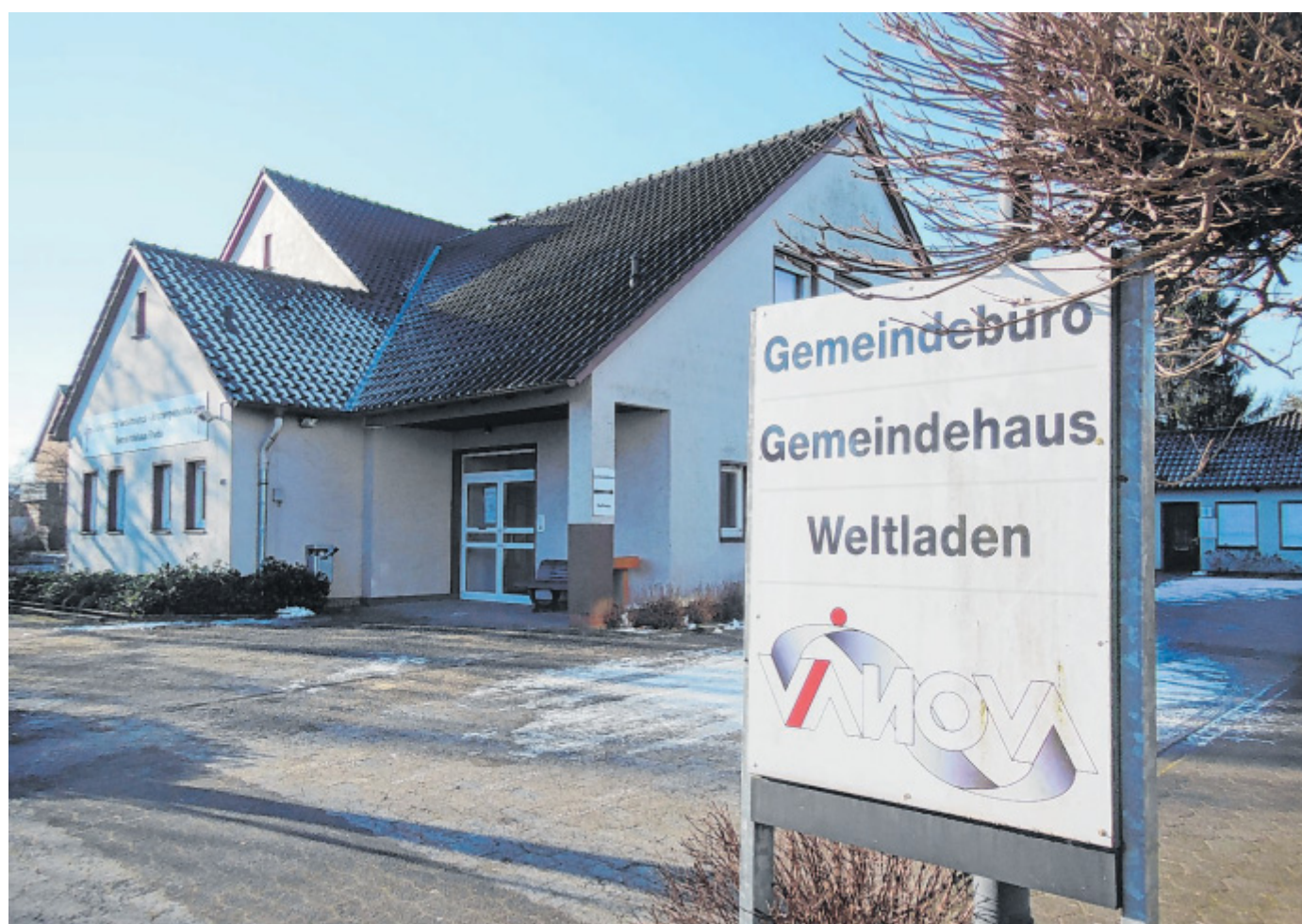
Steht leer: An der Ringstraße waren das Gemeindehaus, das Gemeindebüro und der Weltladen beheimatet. Gibt es keine neue Nutzung für das Grundstück, wird das 1957 errichtete Gebäude abgerissen. FOTO: MARION POKORRA-BROCKSCHMIDT
